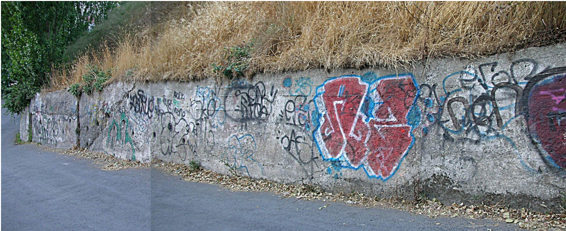
Şekil 3: Nişantaşı-“Teneke Mahallesi” sınırında grafiti duvarı, 2008 (İpek Özmen)
