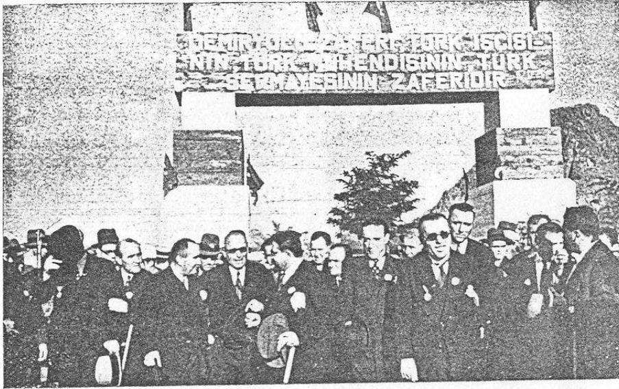
Temel atılan yerdeki tâk önünde
