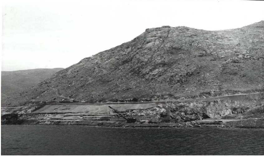
Foto 5. Keban barajı sol sahilinde su kaçaklarını önlemek amacıyla yapılmış çalışmalar. Burada bulunan Petek mağarası ağız kısmı hafriyatla doldurulmuş ve yamaç beton dökülerek kaplanmıştır. Bu durum Keban barajının maliyetinin çok artmasına neden olmuştur.
