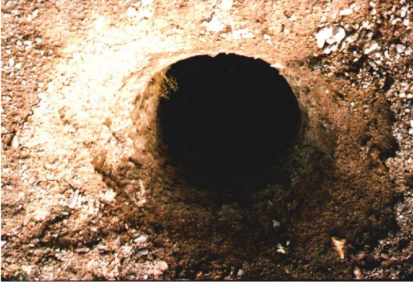
Foto 6. Keban Baraj gölü 832.5 m kotunda iken oluşan 80 cm. çapındaki su kaçağı boşluğu görülmektedir (Foto: N.Özgen).
