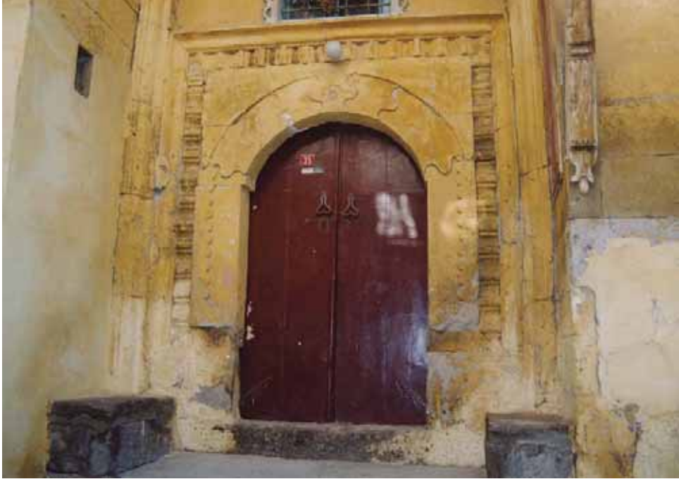
Resim 3: Konaklar Mahallesi 35 Nolu Ev
