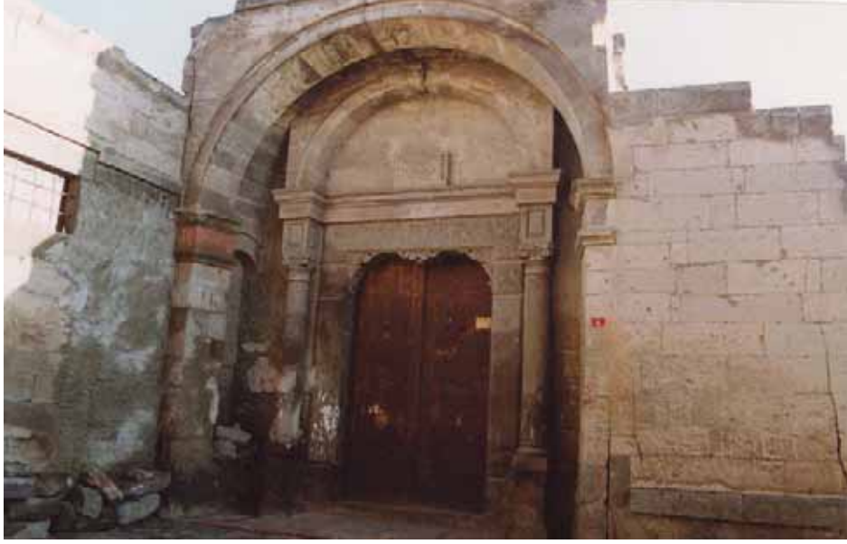
Resim 6: Konaklar Mahallesi 4 Nolu Ev
