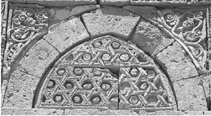
Resim 9. Güneydoğu cephe, güneyden birinci kemer.
