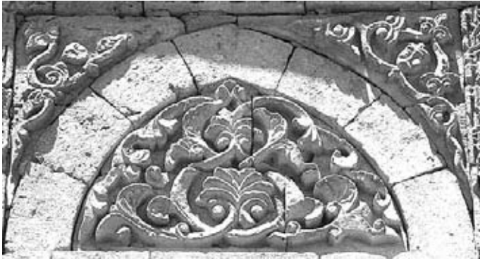
Resim 10. Güneydoğu cephe, güneyden ikinci kemer.
