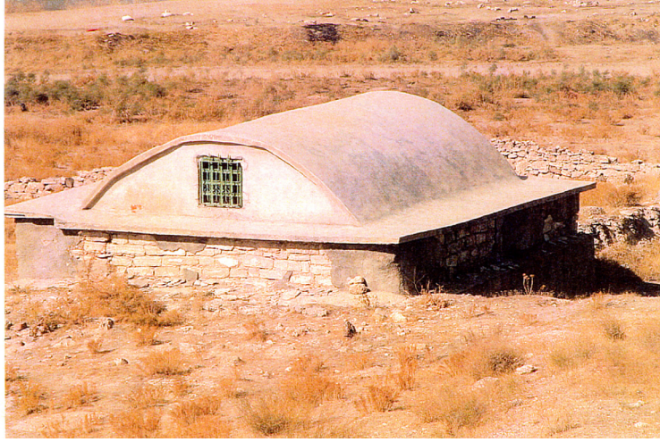
Fotoğraf:5 Türbenin güney cephesi
