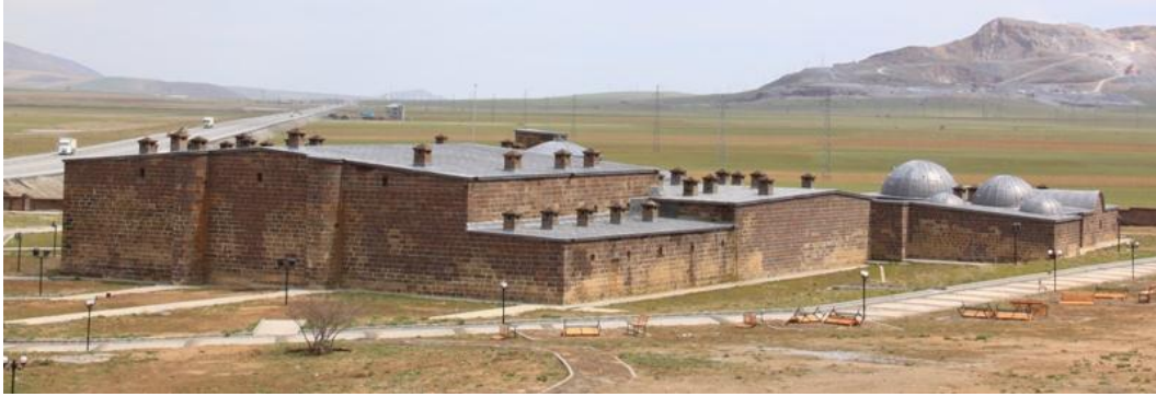
Resim-4 Restorasyon Sonrası Arka Cepeden Genel Görünüm
