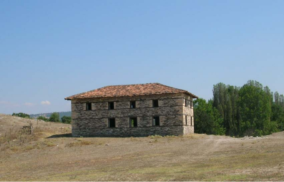
Yapı Özelliklerini Hâlâ Koruyan Çatalsöğüt Köyü Cuma Camisi
