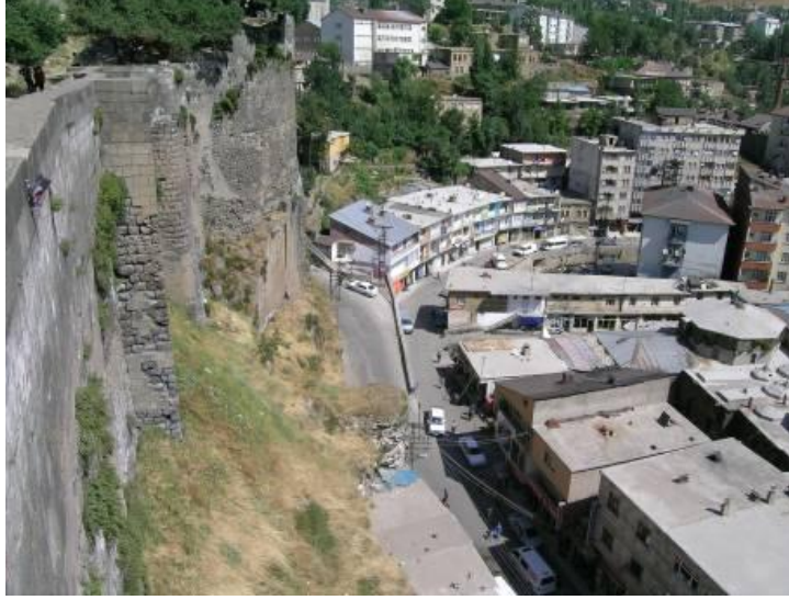
Resim-9: Bitlis Kalesinin kuzeyinde derenin üzerini kapatarak tarihi dokuyu zedeleyen yeni yapılaşmalar. (2005)
