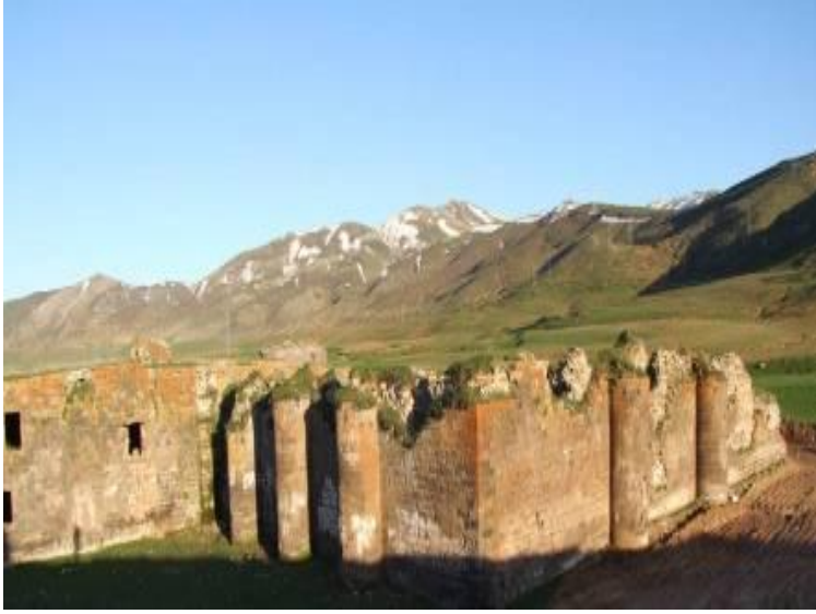
Resim-16: Anadolu'nun en byk hanı olarak bilinen Rahva (El-Aman) Hanı'nın (16.yy) ta ocađı olarak kullanılan yıkık duvarlarının onarım ncesi durumu (2005).
