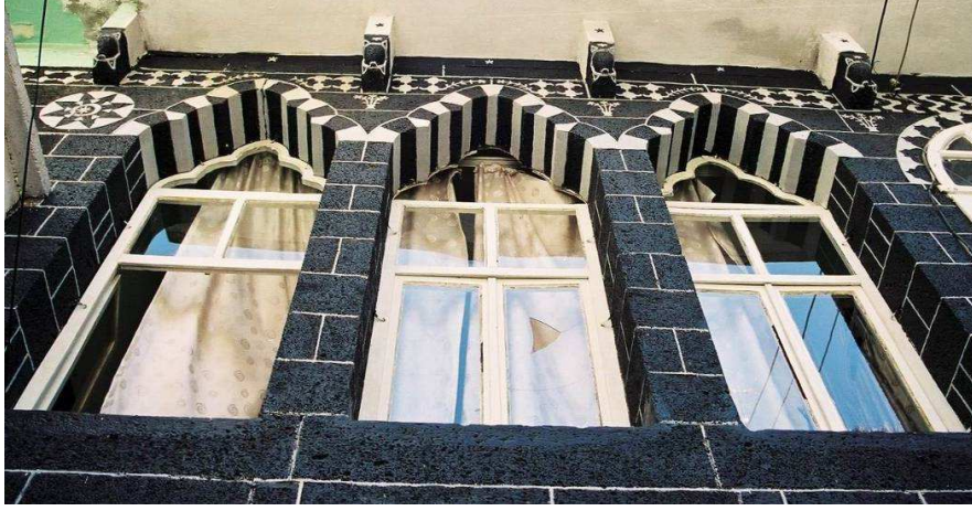
Resim-8: Camii Kebir M. Mze S. 9 nolu konutta dilimli kemer ve konsollarda cas kullanımı
