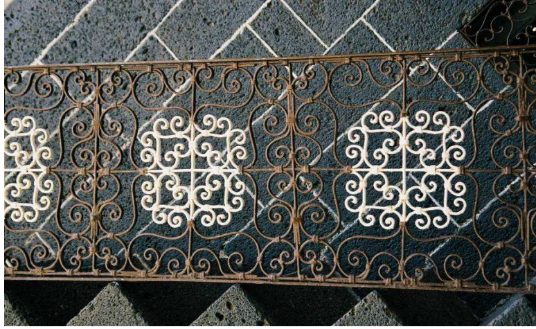
Resim-25: Camii Kebir M. Müze Sokak 9 nolu konut merdiven korkulukları
