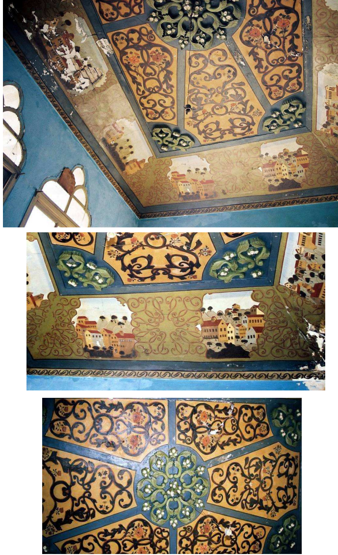
Resim-23: Süleyman Nazif Mahallesinde depo olarak kullanılan bir konutun ahşap tavan kaplaması ve süsleme detayları
