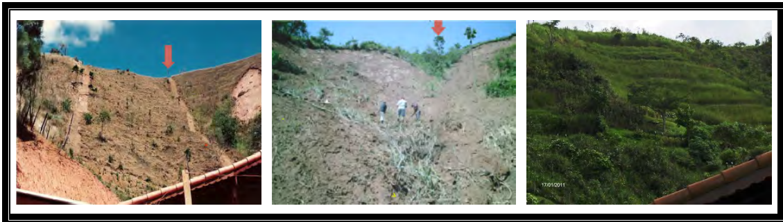
Şekil 10. Vetiver grass bitkisi ile heyelan stabilizasyonu, Brezilya (URL-3, 2011)
