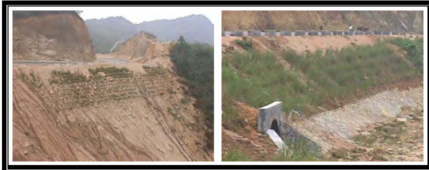
Şekil 11. Güney Çin'de 1997 yılında Jiangxi karayolu kenarında dik bir dolgu stabilizasyonunda Vetiver grass bitkisi kullanımı (URL-4, 2011)
