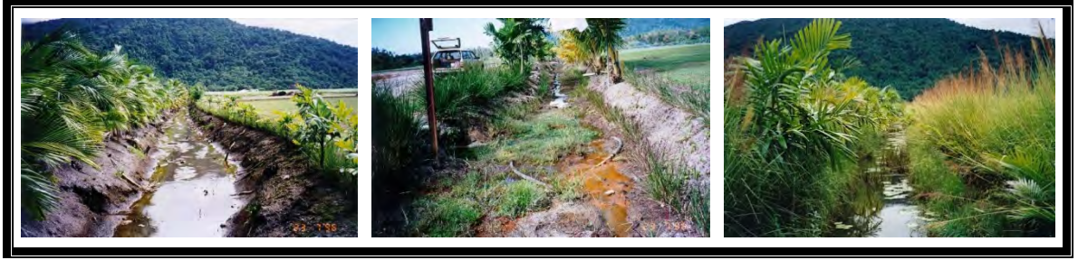
Şekil 13. Asit sülfat topraklarda drenaj koruması, tropik bölgelerde milyonlarca hektarlık asit sülfat toprak vardır. Bu topraklar düşük pH (2-4) ve yüksek aşımım üzerindeki bu topraklar üzerinde pek çok büyüeyebilen bitkiler vardır, Avustralya, Kuzey Queensland (URL-6, 2011).
