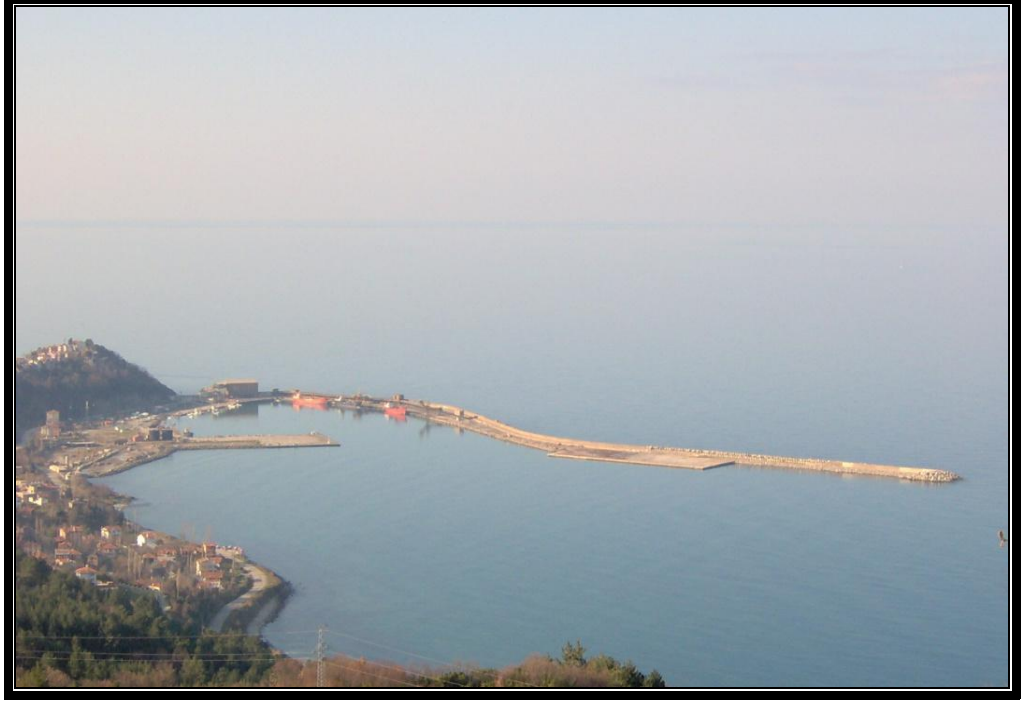
Fotoğraf 3: İnebolu Limanının Tamamlandıktan Sonraki Genel Görünümü. Photograph 3: The scene of Inebolu harbour after its completion.
