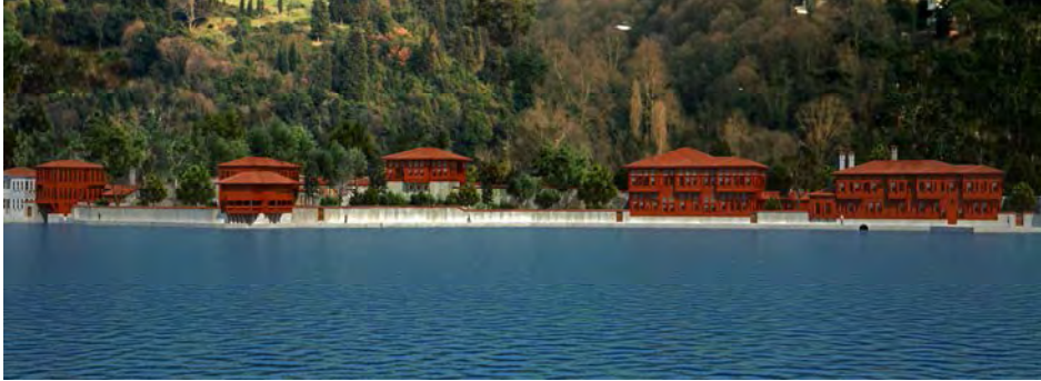
Figür 6: Yalının restorasyonu plânlanan kısımlarının genel görünüşü (2004'ten beri yalıyla ilgili çalışmalar yapan Mimar Özcan Gürsel'in Arşivinden)
