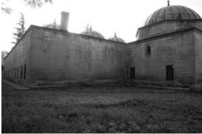
Fot.2. Vezirköprü Fazıl Ahmet Paşa Medresesi
