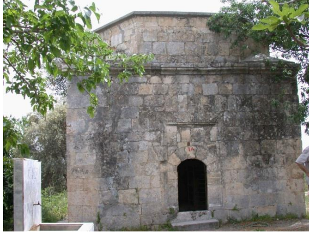
Fotoğraf 13- Camili (Gökçeli) Köyü Türbesi, kuzey cephesi.
