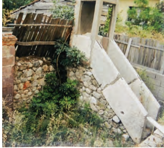
Resim. 3 Veziroköprü Köprülü Mehmed Paşa Namazgâhı Kuzey Doğudan (2008 Restorasyon Öncesi - 2003).
