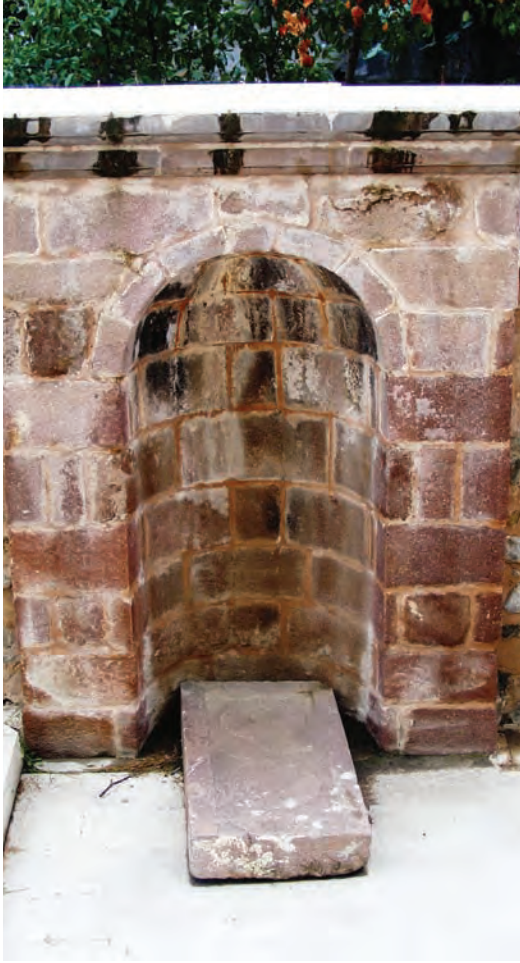
Resim. 7 Vezirköprü Köprülü Mehmed Paşa Namazgâhı Mihrabı. (2008 Restorasyon Sonrası).
