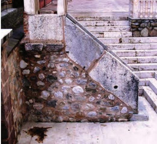
Resim. 4 Veziroköprü Köprülü Mehmed Paşa Namazgâhı Minberi Doğu Yüzü. (2008 Restorasyon Sonrası).
