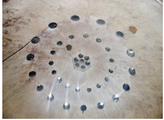
Fotoğraf 19: Kadınlar bölümü, sıcaklık, filgözü pencereler. (Asır Proje Arşivi, Mart 2010)
