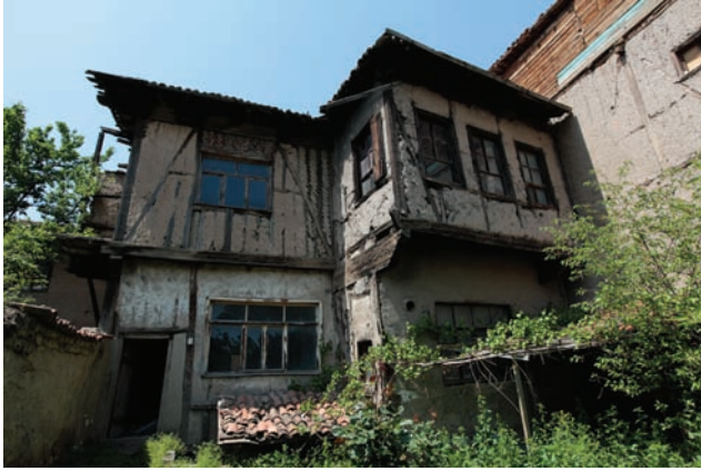
Fotoğraf 3. Konut doğu cephe ve bahçe
