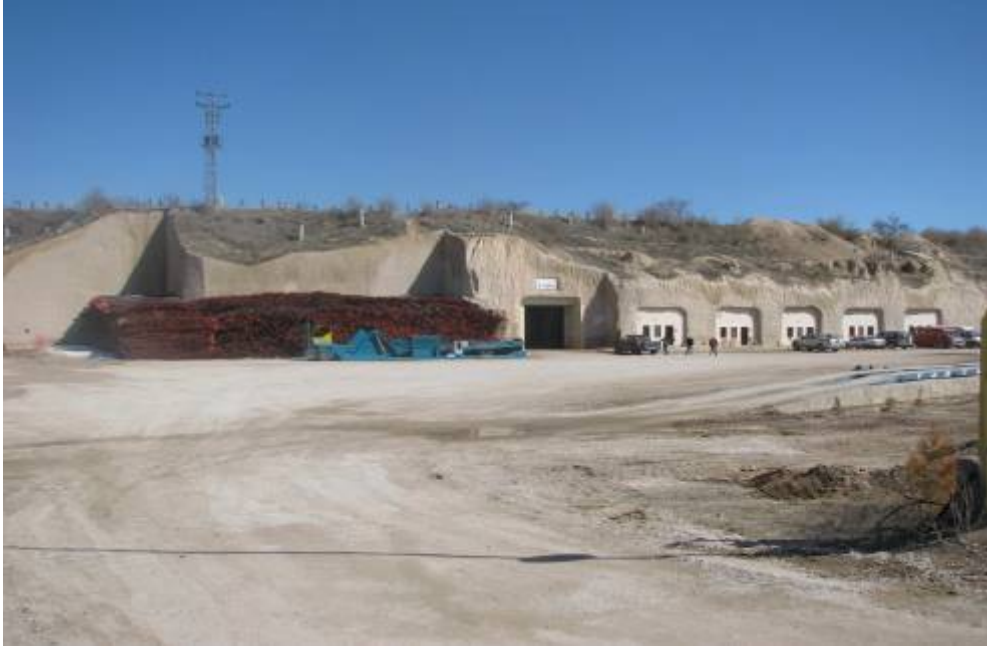
Foto 9: Patates Tohumculuğuna Dayalı Bir Cips İşletmesinin 100.000 Ton Dökme Patates Saklanabilecek Kapasitedeki Yer Altı Doğal Soğutmalı Depolarından Bir Görüntü
