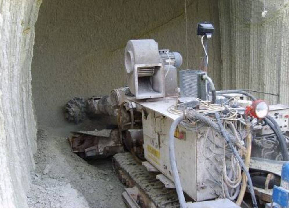
Foto 3: Kavak Kasabasında Yeni Yapımına Başlanan Bir Yer Altı Soğuk Hava Deposunun Kazı İşlemlerinden Görünüm
