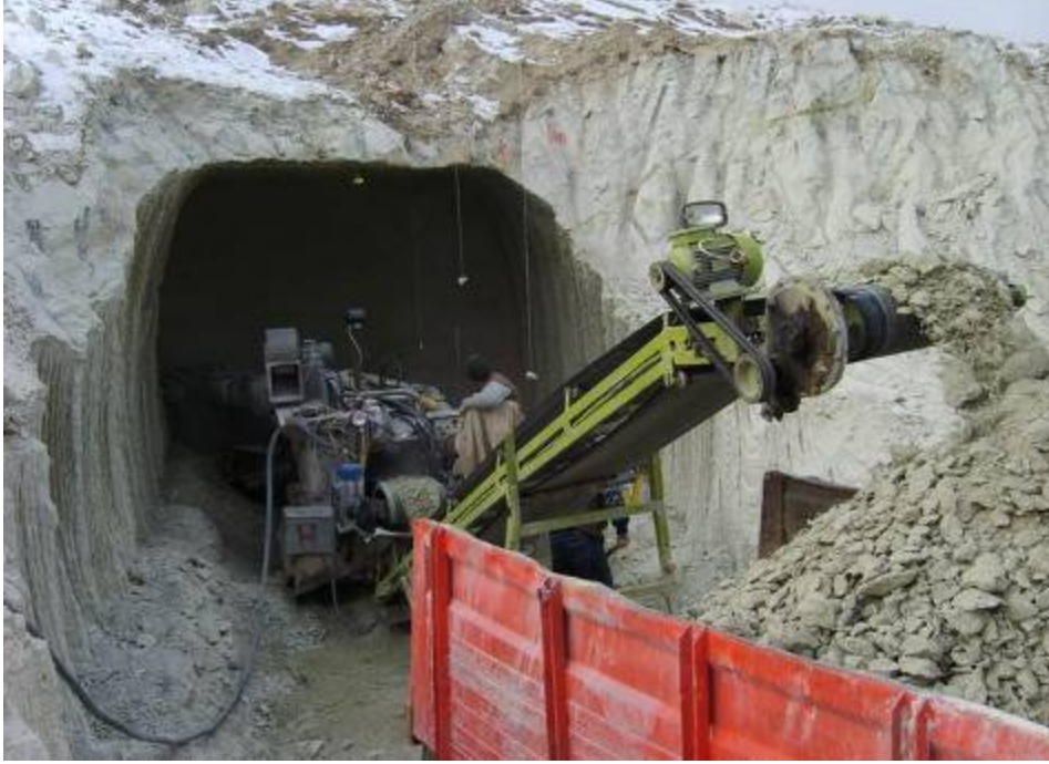
Foto 4: Kavak Kasabasının'da Yeni Yapımına Başlanan Yer Altı Soğuk Hava Deposunun Kazı İşlemleri Sırasında Çıkarılan Harfiyatın Yüklenecek Taşınmasından Bir Görünüm
