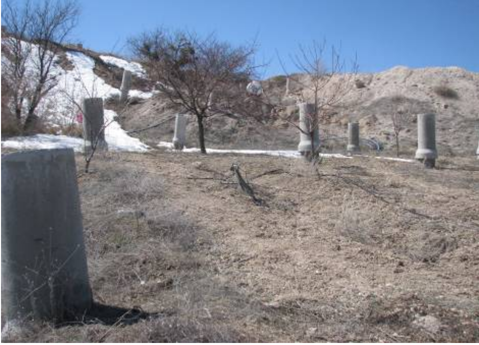
Foto 5: Kavak Kasabasının'da İşletme Halinde Olan Yer Altı Soğuk Hava Deposunun Havalandırma Bacalarından Bir Görünüm
