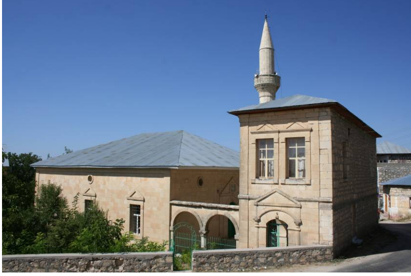
Foto.4: Cami ve mektebin kuzeydoğudan görünüşü.
