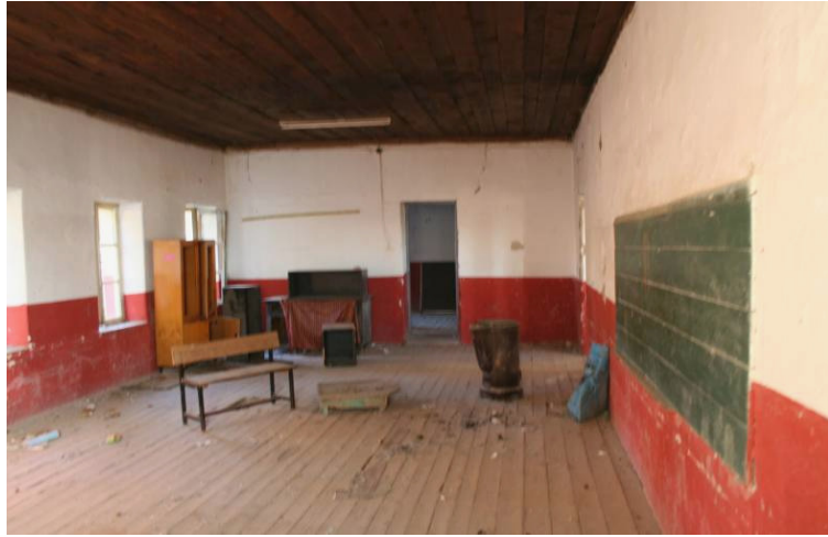
Foto.19: İlkokul, kuzey cephedeki sınıf genel görünüşü.
