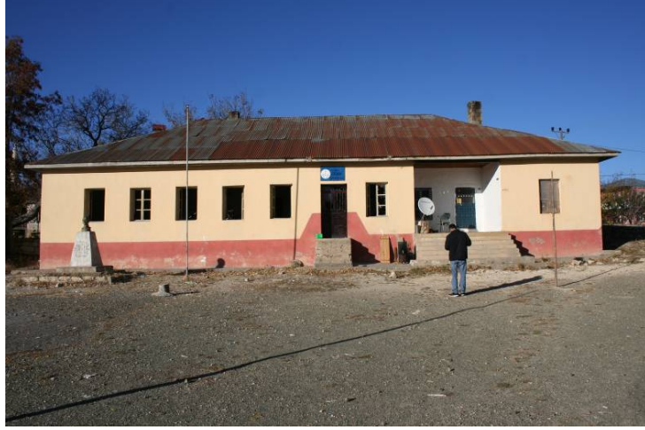
Foto.16: İlkokul ve lojmanın güney cephe, genel görünüşü.
