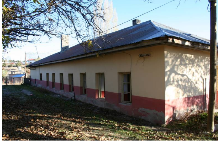
Foto.17: İlkokul ve lojmanın kuzey cephe, genel görünüşü.
