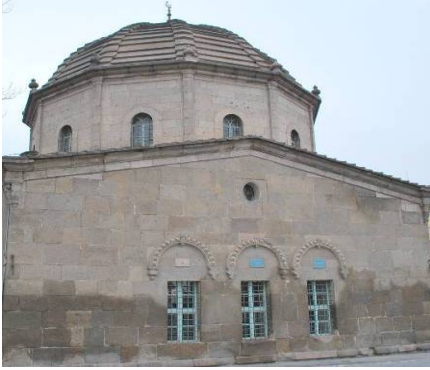
Foto. 3: Kuzey Cephe Görünüşü
